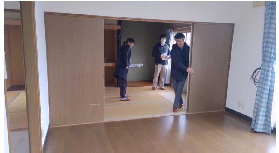
R5.11.20:空き家現地調査(旧農済住宅)
