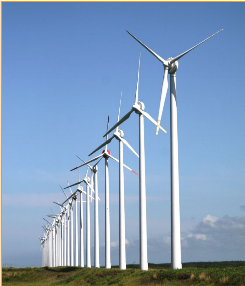
(字浜里 オトンルイ風力発電所)
