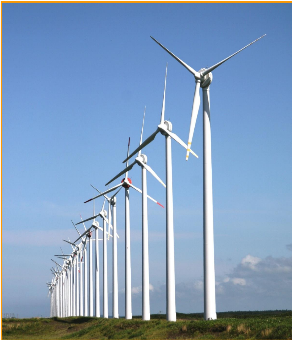
(字浜里 オトンルイ風力発電所)
