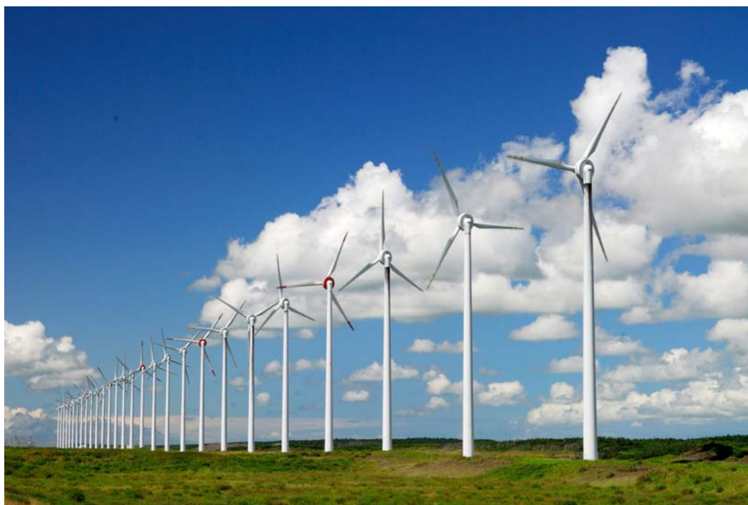
写真 オトンルイ風力発電所
