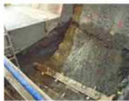
切り欠きの掘削とプラグの施工例
