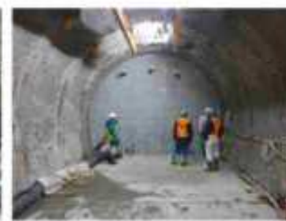
切り欠きの掘削とプラグの施工例
