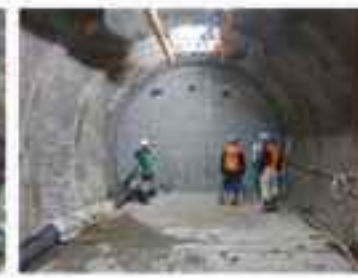
切り欠きの掘削とプラグの施工例
