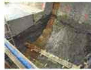
切り欠きの掘削とプラグの施工例
