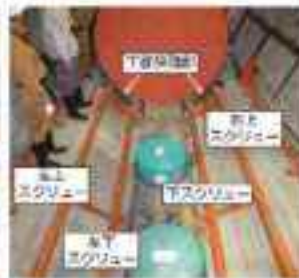
スクルー方式による埋め戻し材の施工
