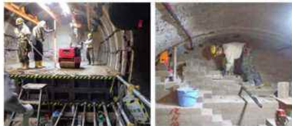
埋め戻し材の施工(左:転圧締め固め、右:ブロック積み上げ)
