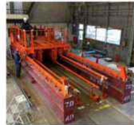
スクリー方式による埋め戻し材の施工
