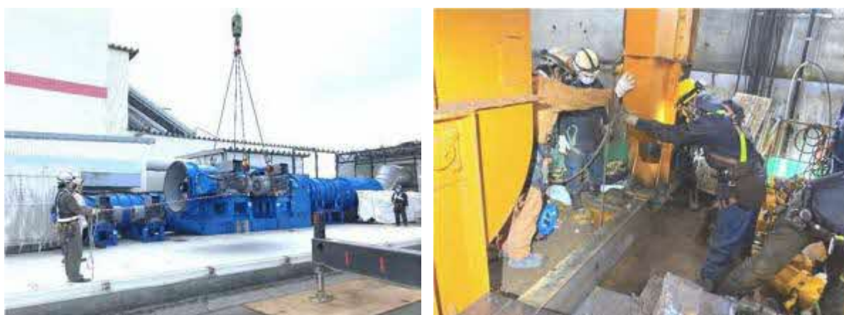
(a) 坑内換気設備の更新
