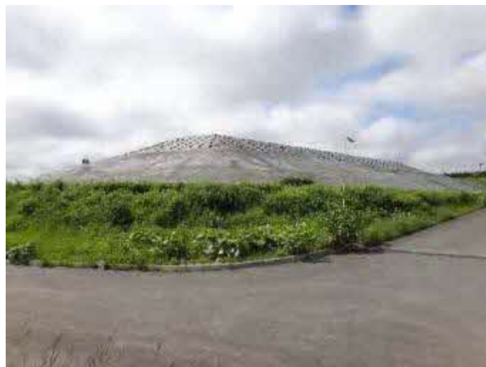
図 126 掘削土（ズリ）置場
