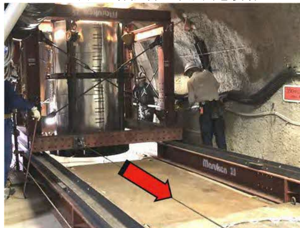
(d) 門型架台ごと一体試料を取り出し
