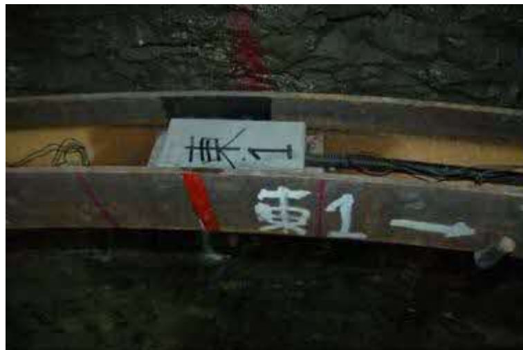
図 116 鋼製支保工応力計設置例
