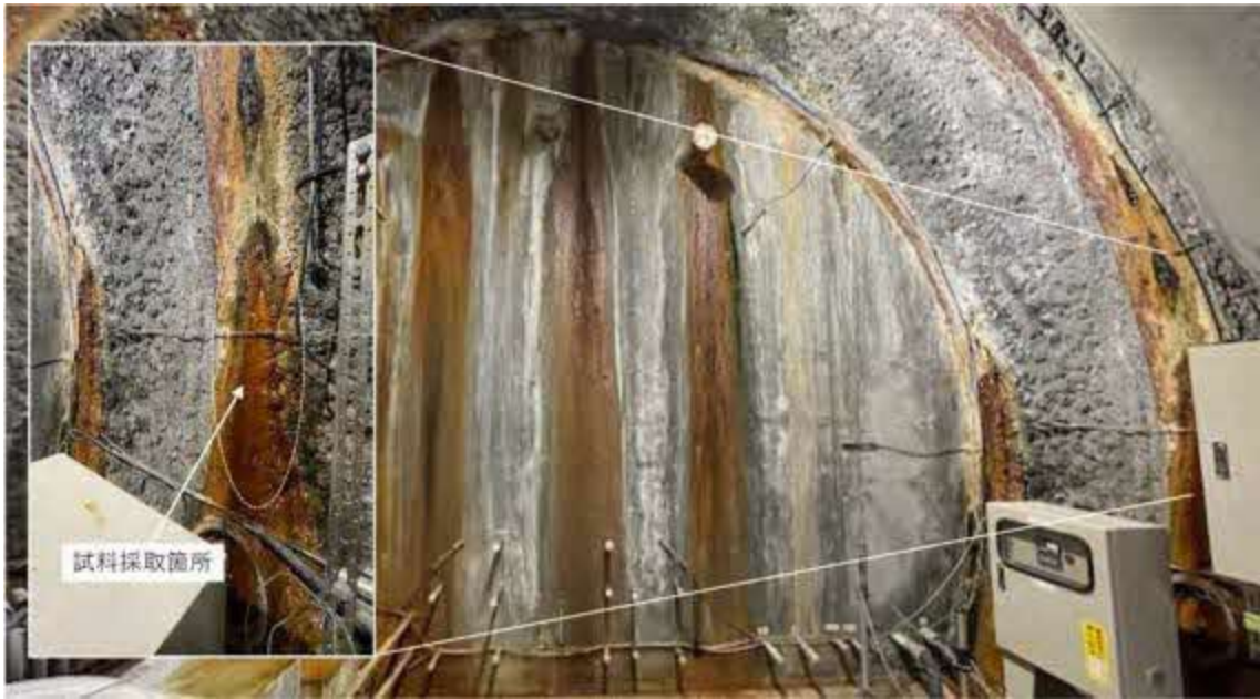
図 106 試験坑道 4 壁面からの浸出水の採取箇所
