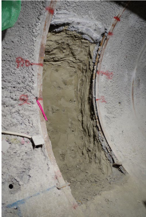
(a) 坑道側面に設けた切欠き部
