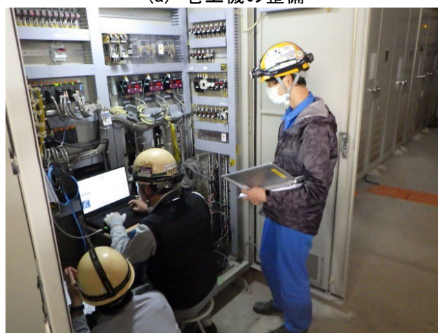
(b) 制御盤の整備
