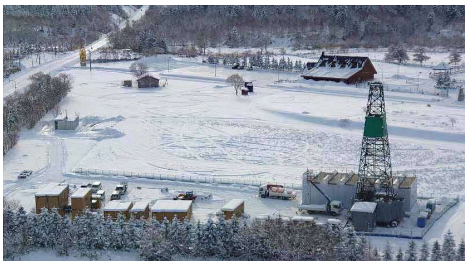
ボーリング調査現場の全景
