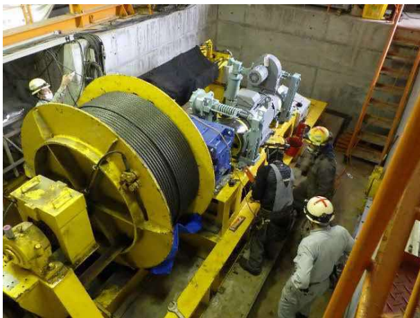
(a) 巻上機の整備
