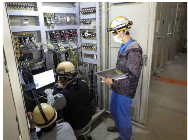
(b) 制御盤の整備
