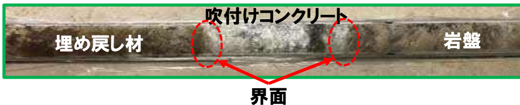
埋め戻し材、吹付けコンクリート、岩盤界面サンプリング後の試料
