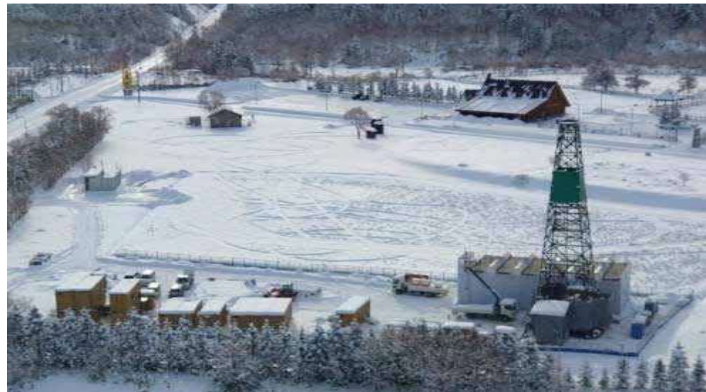
ボーリング調査現場の全景
