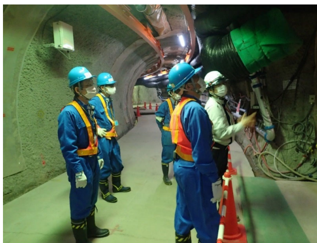
安全パトロールの様子
