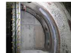
底盤・側面 コンクリート打設
