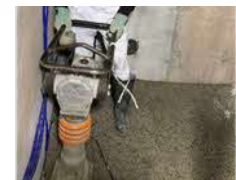
埋め戻し材 転圧締め固め
