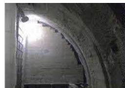
埋め戻し材 ブロック設置
