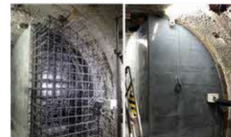
鉄筋組立・ コンクリートプラグ打設
