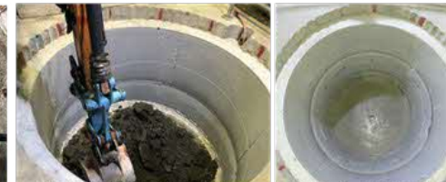
人工バリア試験孔掘削・ コンクリート支保打設
