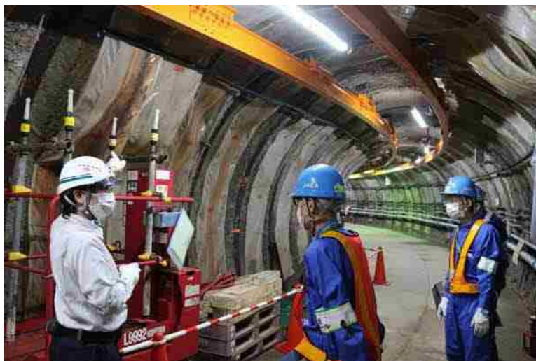
安全パトロールの様子
