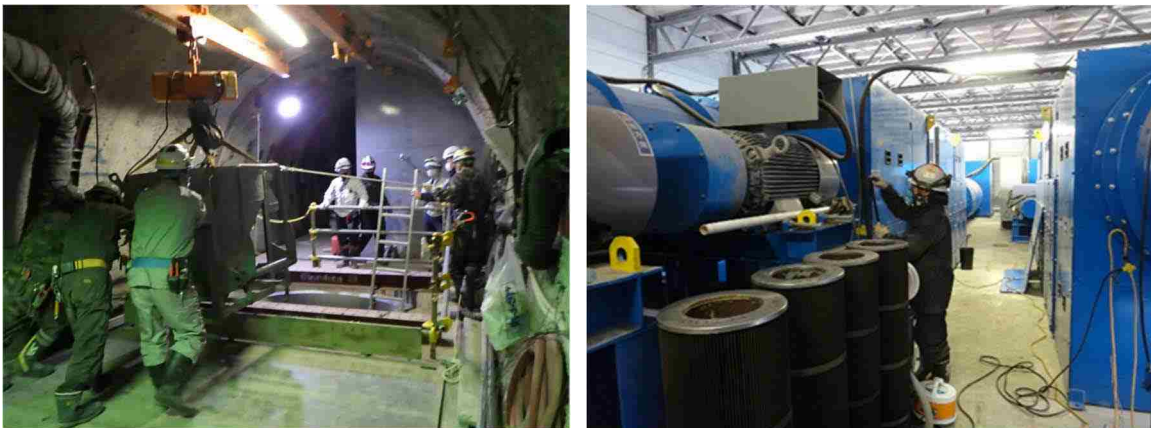
工事および維持管理の様子
