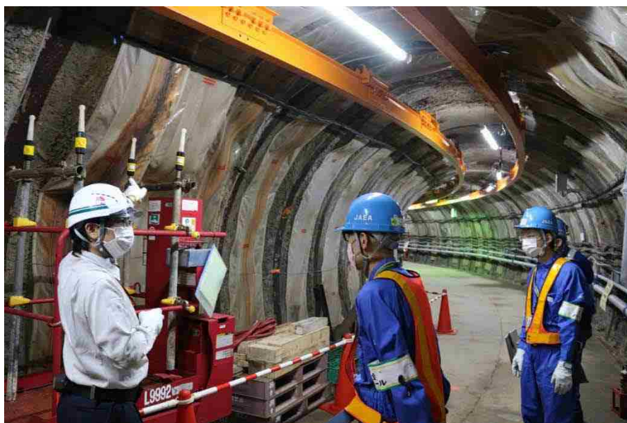
図 33 安全パトロールの様子
