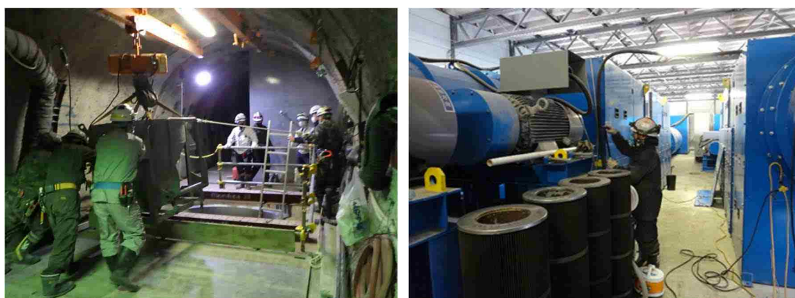
図 30 工事および維持管理の様子
