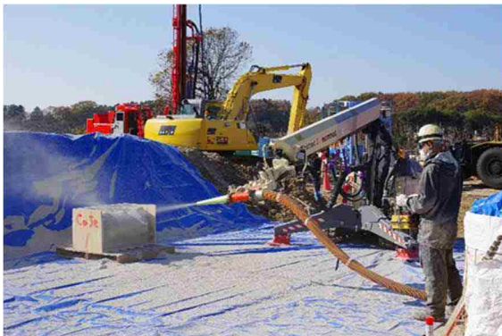
ベントナイト材料の吹付け状況
