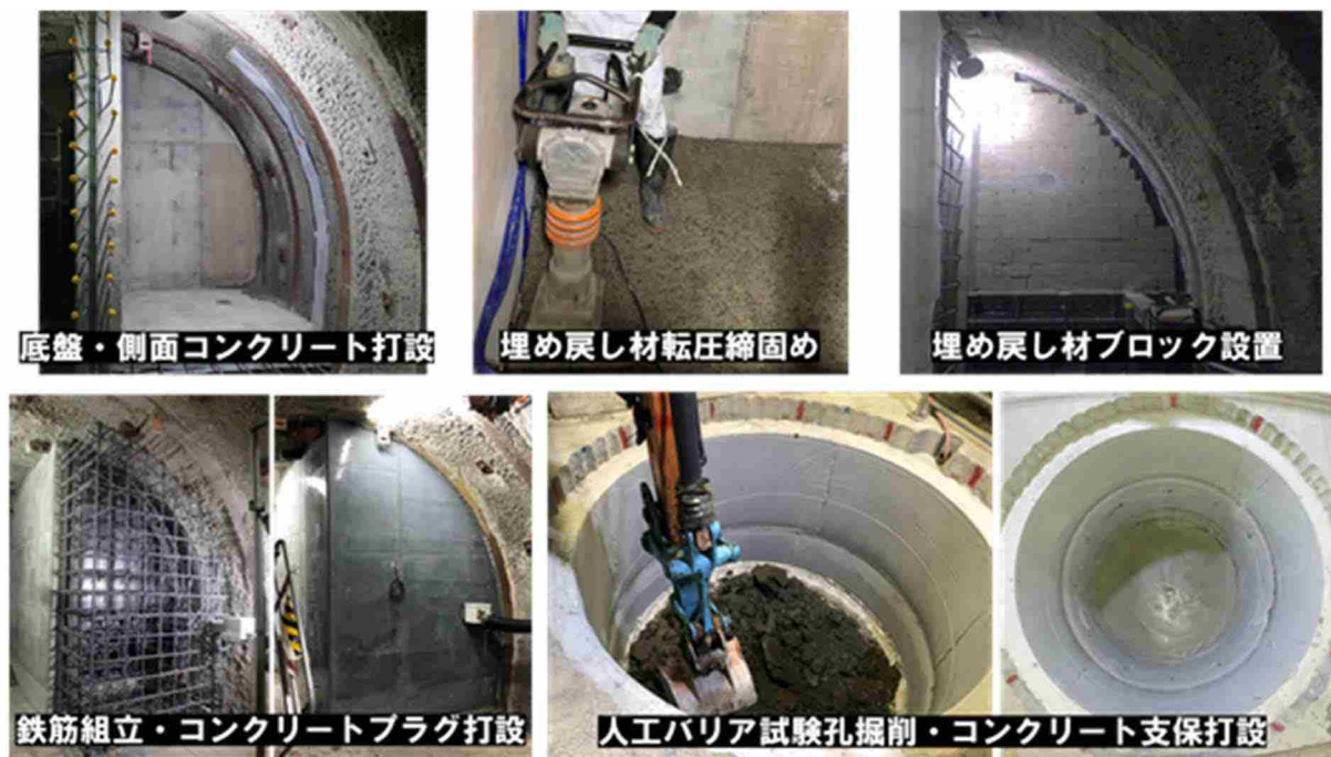
図 10 人工バリア解体試験施工の施工状況
