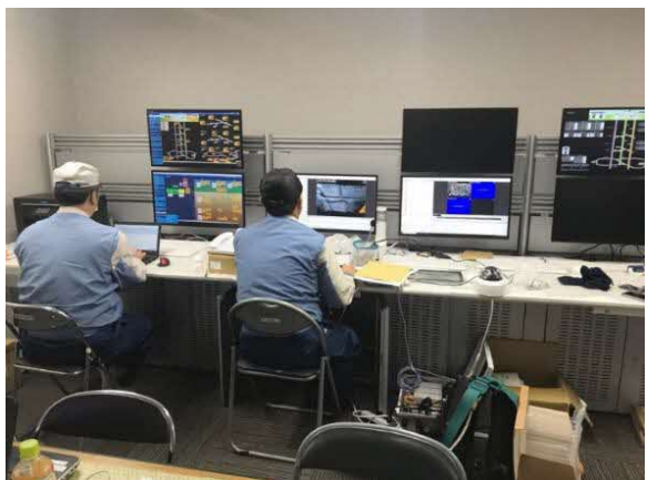
中央管理室の写真
