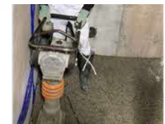
埋め戻し材 転圧締め固め
