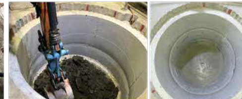
人工バリア試験孔掘削・ コンクリート支持打設
