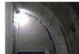
埋め戻し材 ブロック設置
