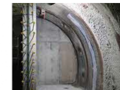
底盤・側面 コンクリート打設
