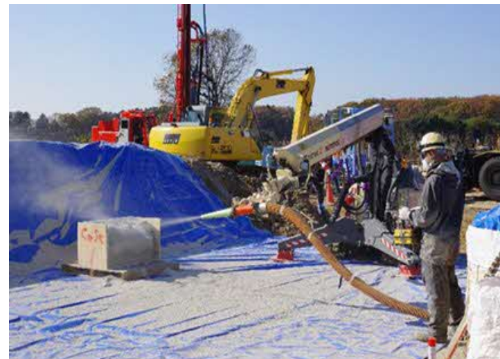
ベントナイト材料の吹付け試験
