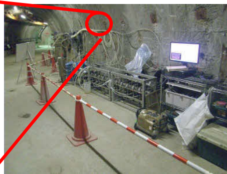
透水試験実施状況
