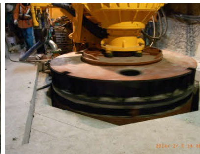
試験孔の掘削中の様子
