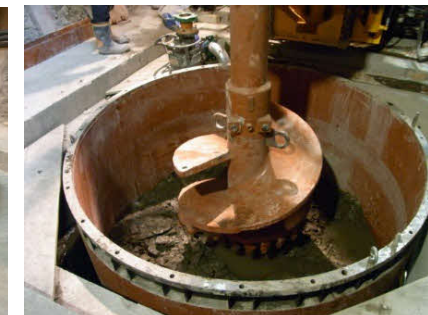
試験孔の掘削中の様子
