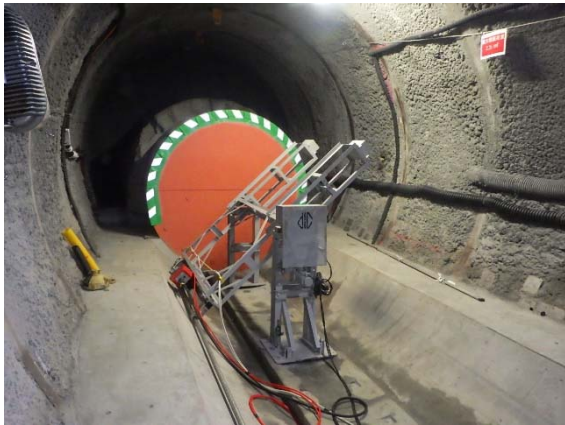
写真 6 ウォータジェット方式の装置とノズル
