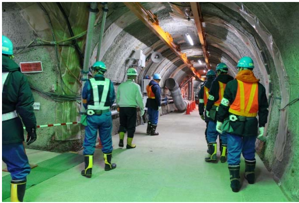
写真 17 安全パトロールの状況
