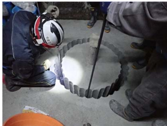
(c) 人力による突き固め
