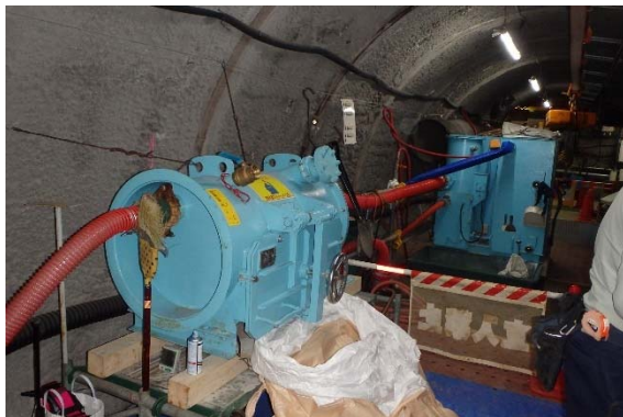
写真 5 吸引機の外観と、捕集した充填材
