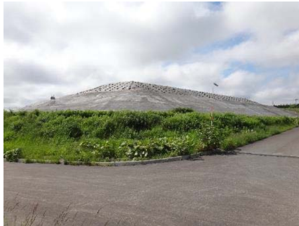
写真 10 掘削土（ズリ）置場
