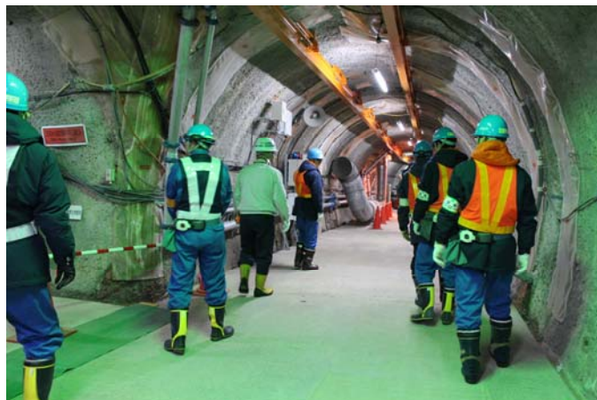
写真 17 安全パトロールの状況
