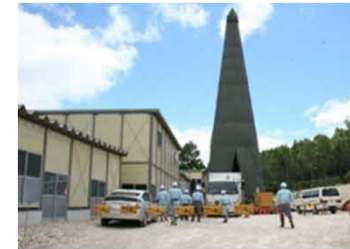
地上からのボーリング調査
