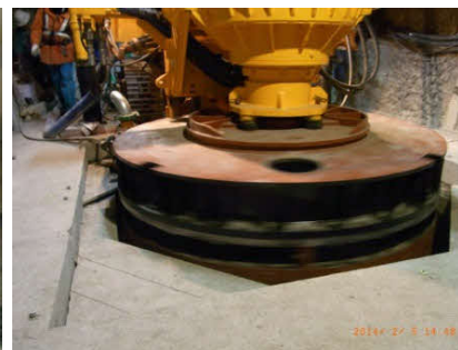
試験孔の掘削中の様子
