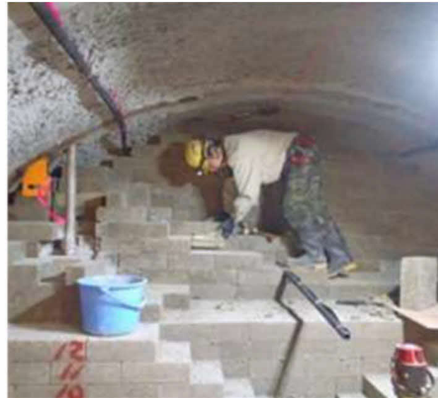
(上:ブロック積み上げ)
