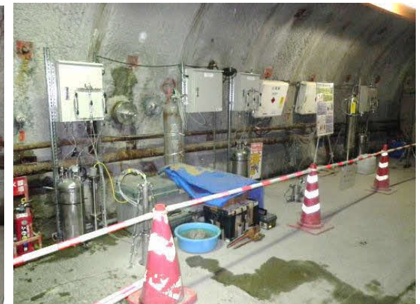
装置設置状況
