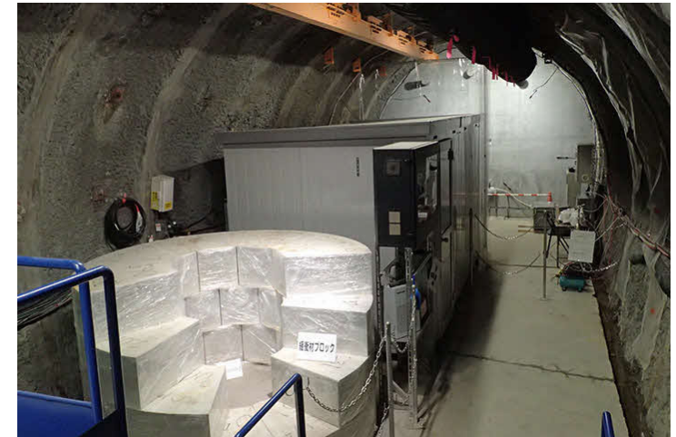
深度350m調査坑道 試験坑道4 人工バリア性能確認試験実施箇所 (平成28年5月11日撮影)
