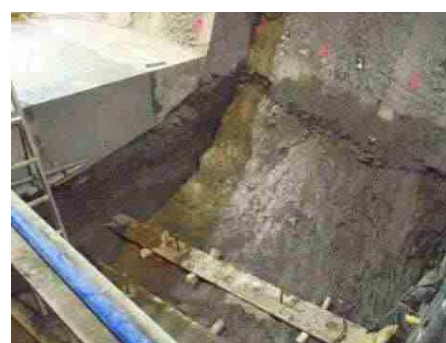
切り欠きの掘削とプラグの施工例
