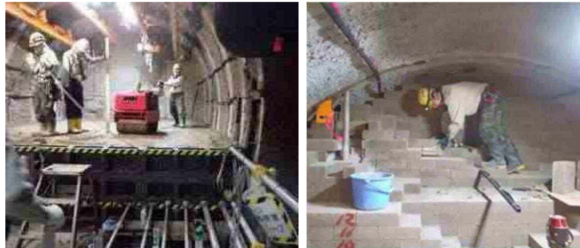
埋め戻し材の施工(左:転圧締固め、右:ブロック積み上げ) 10
