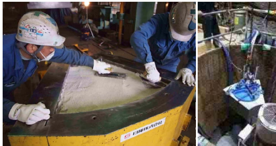
緩衝材ブロックの製作と試験孔への定置
