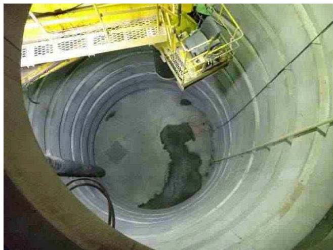
西立坑 (平成26年3月26日撮影)
