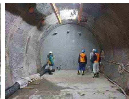
切り欠きの掘削とプラグの施工例
