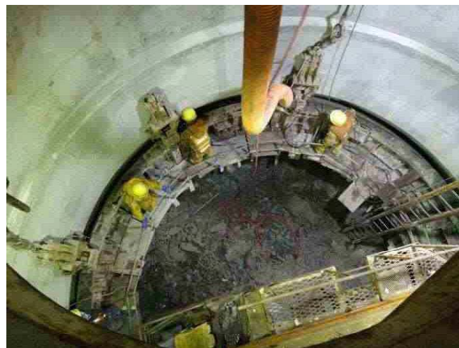
東立坑 (平成26年3月26日撮影)
