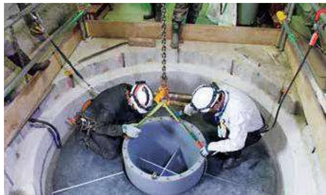
写真 模擬の人工バリアを設置している様子 令和3年度はこれらの解体方法を検討する試験を行います
