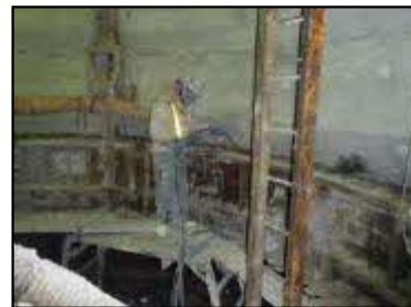
⑧コンクリート打設
