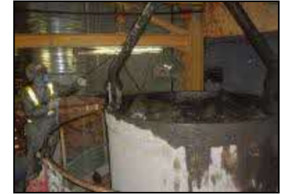
③掘削土(ズリ)出し
