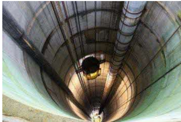
直径6.5m (西立坑)
