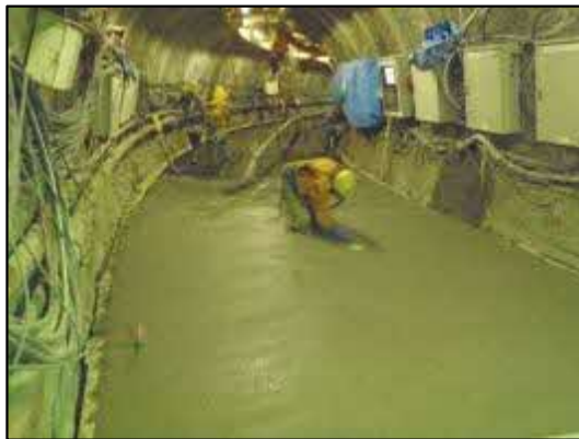
路盤コンクリート打設
