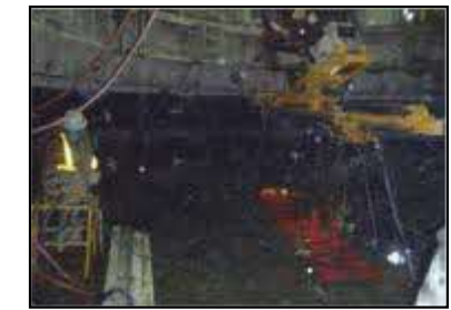
⑥ロックボルト設置
