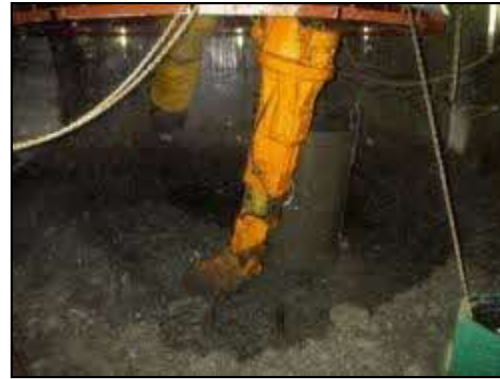
換気立坑積込機製作
