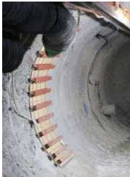
図 43 吹付け試験施工後の養生
