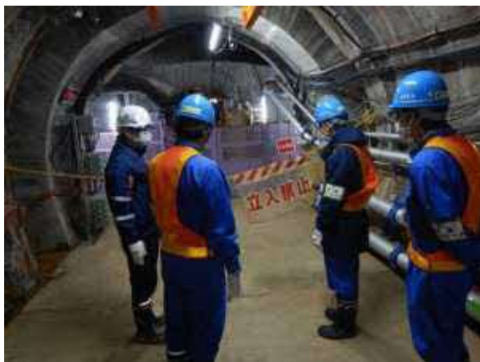
図 136 安全パトロールの状況 令和4年4月11日の実施状況
