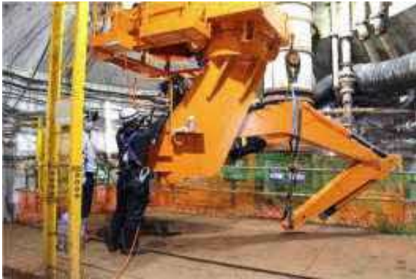
(a) 積込機の整備
