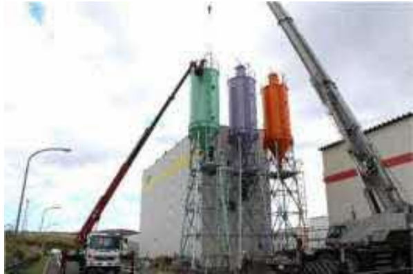
(b) セメントサイロの設置
