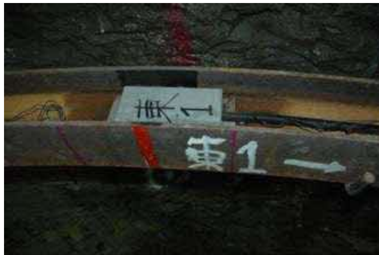
図 111 鋼製支保工応力計設置例
