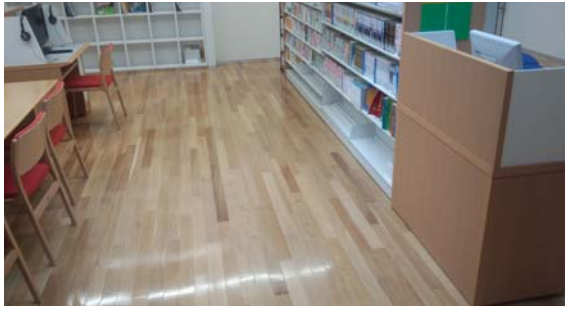
生涯学習センター床施工完了
