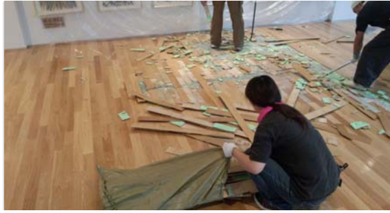
生涯学習センター施工状況
