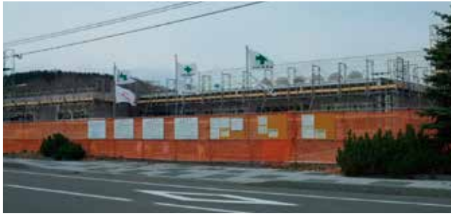
認定こども園建設状況
