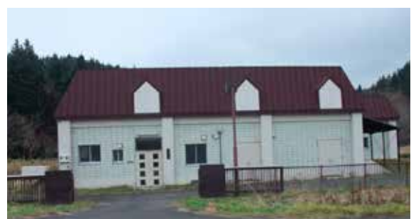
上幌延浄水場
