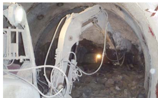
周回坑道(東)東側から撮影した貫通箇所
