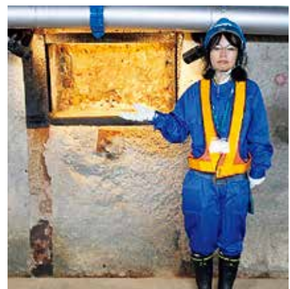
写真2 深度250m調査坑道の岩盤
