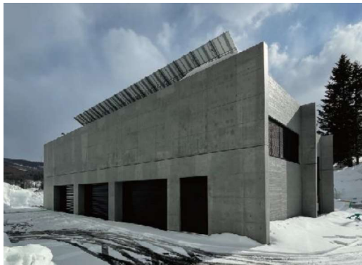
古平町複合施設かなえーる 防災棟 (古平町 HP)
