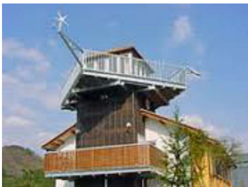
福井県 越前市エコブリッジ交流センター 「風の館さかのくち」風力(展望塔) (福井県 越前市エコブリッジ交流センター 「風の館さかのくち」HP)
