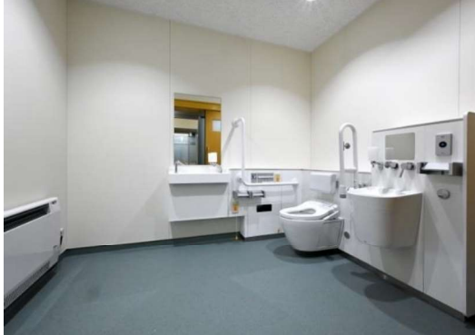
道の駅 風 W(ふわっと)とままえ 多目的トイレ (苫前町 HP)
