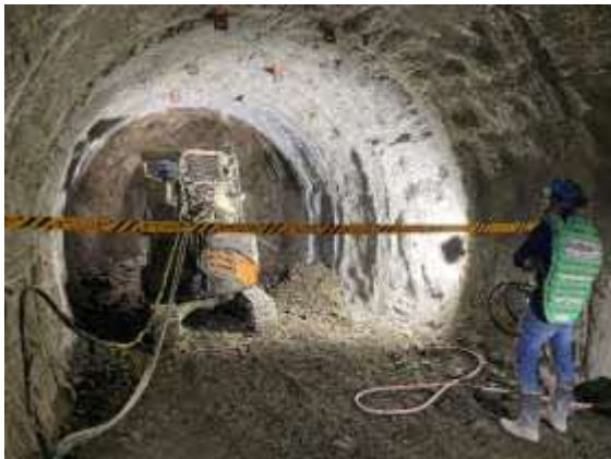
試験坑道7掘削状況
