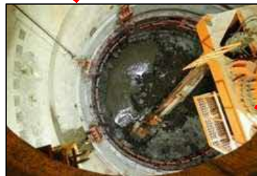
②掘削 ブレーカーで岩盤を砕きます。
