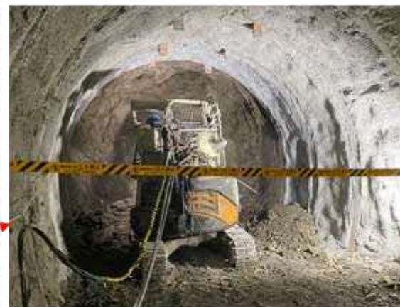
試験坑道7の掘削の様子
