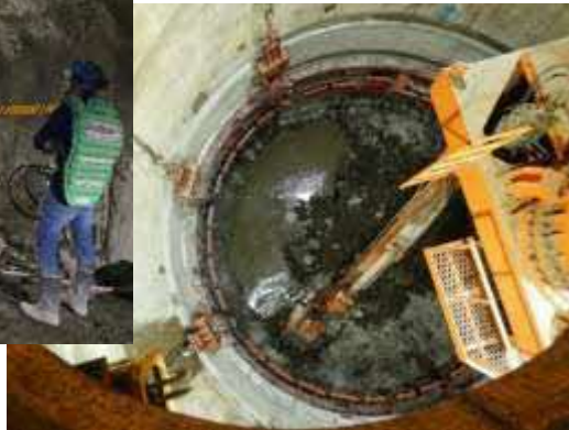
東立坑掘削状況
