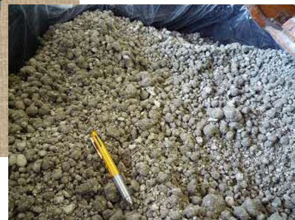
掘削土（ズリ）を用いた埋め戻し材
