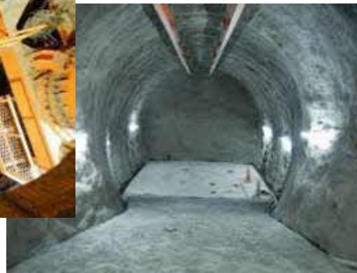
東立坑側第1ボーリング横坑
