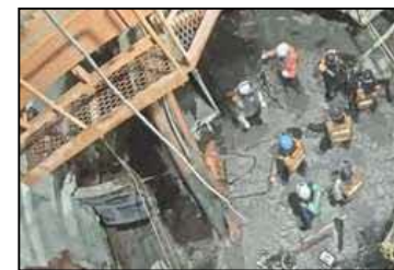
⑨型枠脱型 流し込んだコンクリートが固まった後に型枠を外します。
