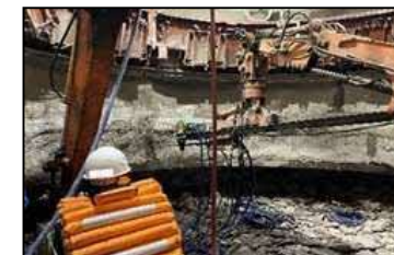
⑥ロックボルト設置 岩盤中にロックボルト（鉄製のロッド）を打ち込み補強します。
