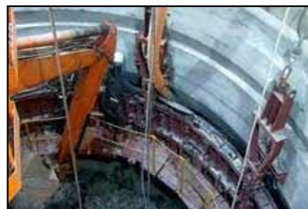
⑧コンクリート打設 設置した型枠と岩盤の壁面の間にコンクリートを流し込みます。
