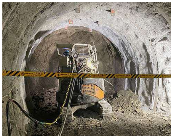
(b) 掘削の様子
