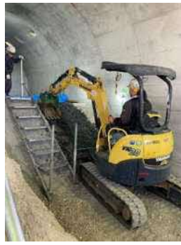
(b) 斜め転圧工法
