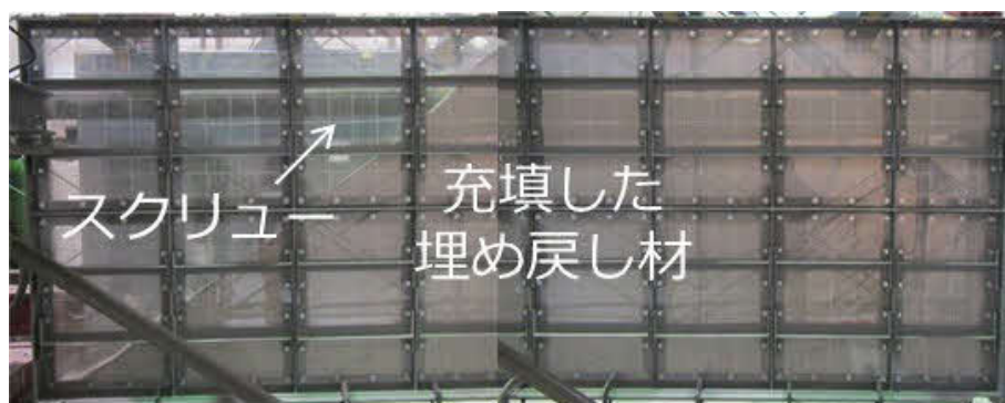
図 48 スクリー工法による埋め戻し材の充填後の外観
