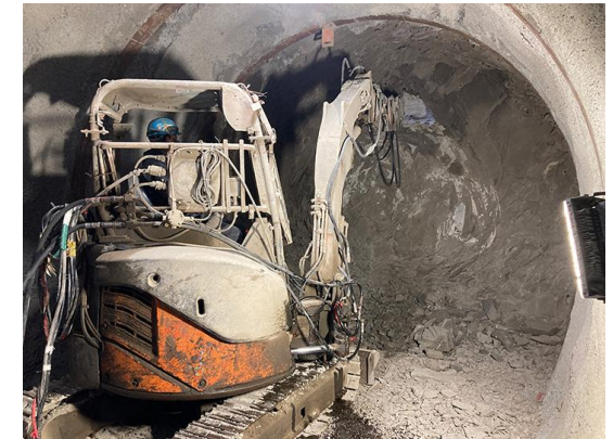
東連絡坑道の貫通（R7.2.18）
