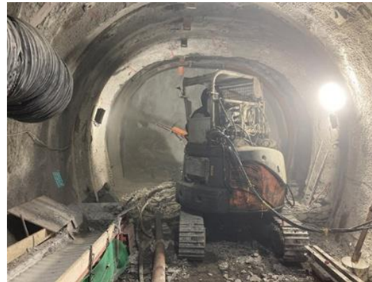
500m東連絡坑道の掘削（R6.12.20）
