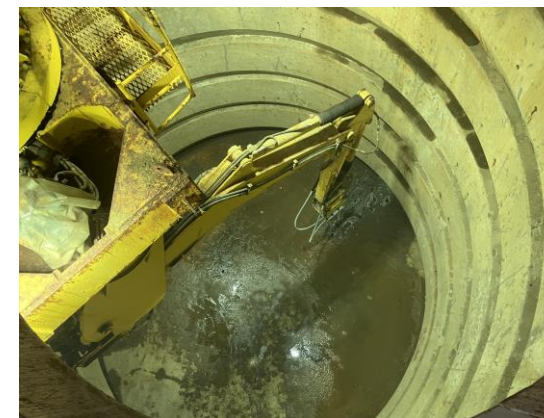
西立坑 深度365m掘削開始（R6.9.11）
