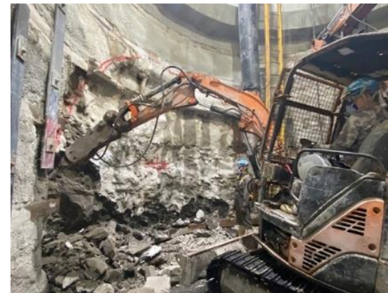
深度500m坑道掘削開始（R6.9.17）
