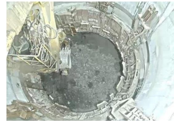
換気立坑 深度500m到達（R7.1.22）
