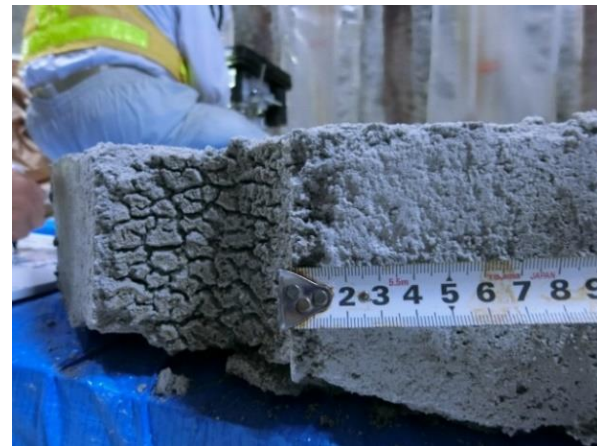
緩衝材ブロックのひび割れ
