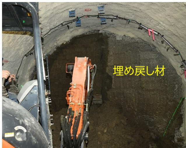
埋め戻し材の切削
