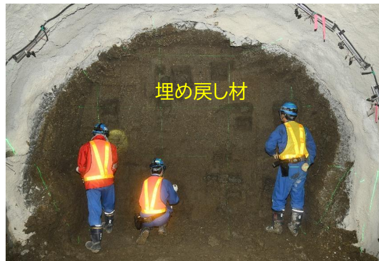
埋め戻し材のサンプリング、観察
