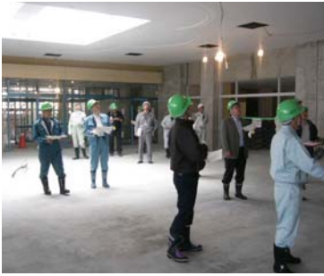
北星園建設現場
