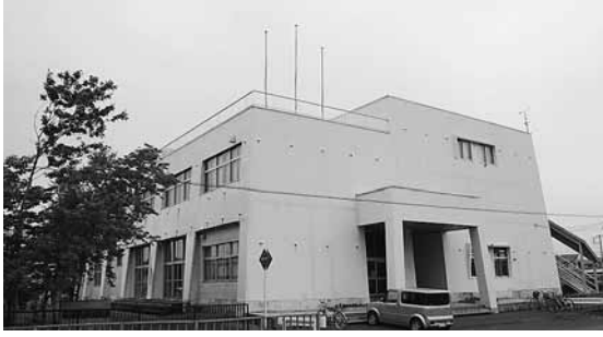
現在の幌延町公民館
