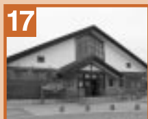
17 幌延ビジターセンター
