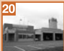
20 幌延消防支署 【北留萌消防組合】
