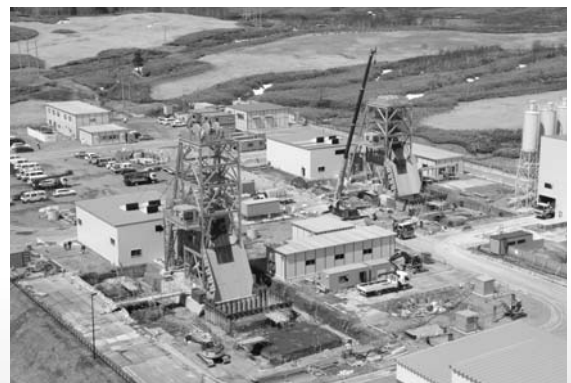
P R施設展望タワー(地上50m)から望む地下施設建設現場
