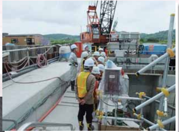
▼幌延深地層研究センター西立坑掘削現場
