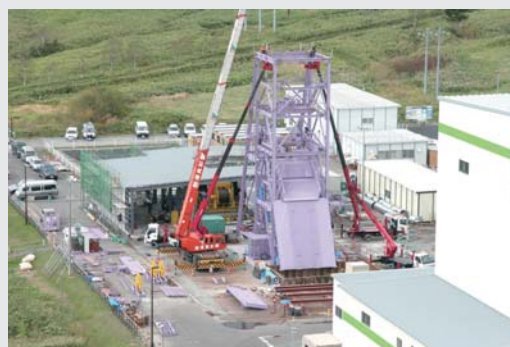
西立坑工事のようす
