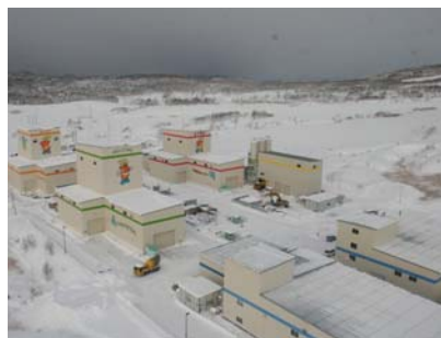
地下施設外観(ゆめ地層館展望台より撮影)
