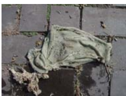
除去した異物4
