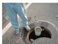
灯油引抜作業
