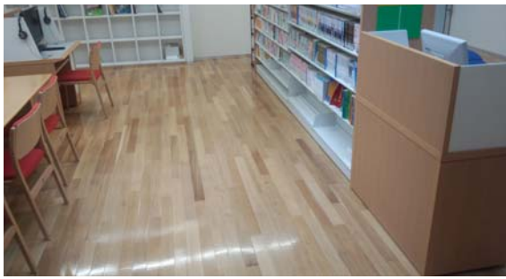
生涯学習センター床施工完了
