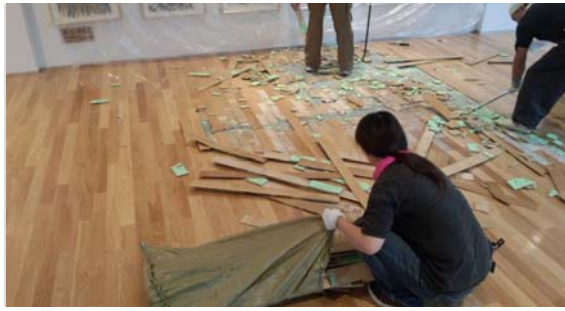
生涯学習センター施工状況
