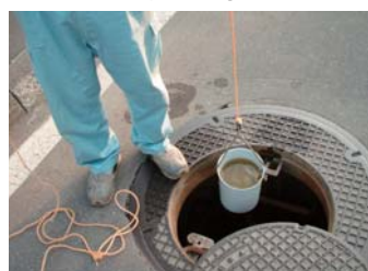
灯油引抜作業
