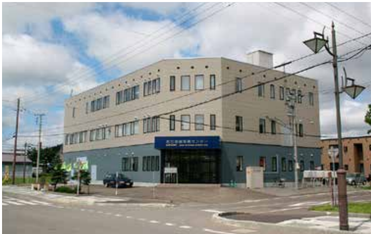
幌延地圏環境研究所
