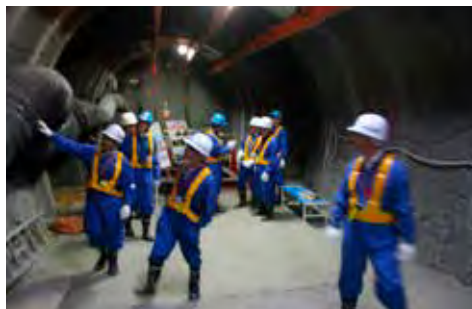
350m坑道視察
