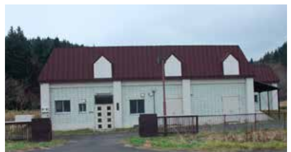
上幌延浄水場
