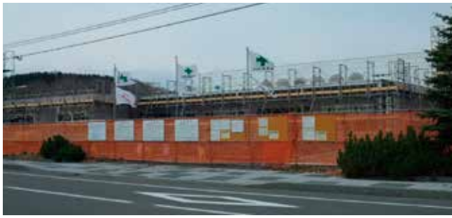
認定こども園建設状況
