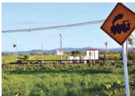
国鉄時代の踏切標識が残る踏切より見た、糠南駅ホームと待合室
