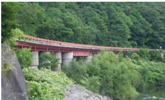
町道雄興1号線 下平橋
